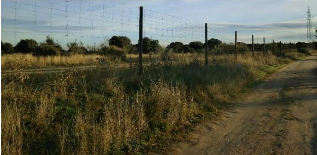
Detalle del cerramiento ejecutado.
