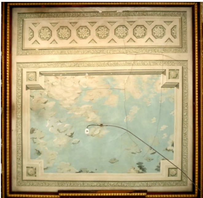
Fotografía del techo recuperado
