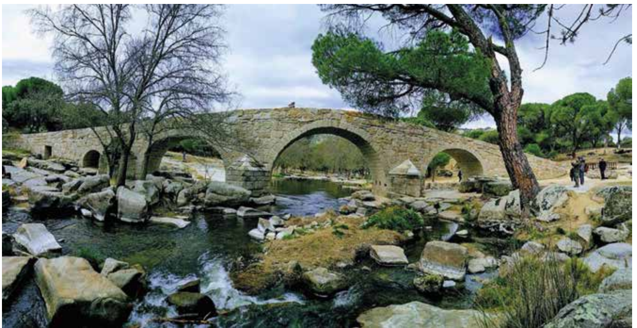
Foto: Puente Mocha sobre el río Cofio
