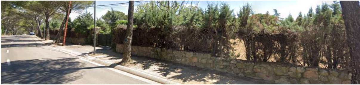
Fotografía del acceso desde la Calle Valle del Roncal
