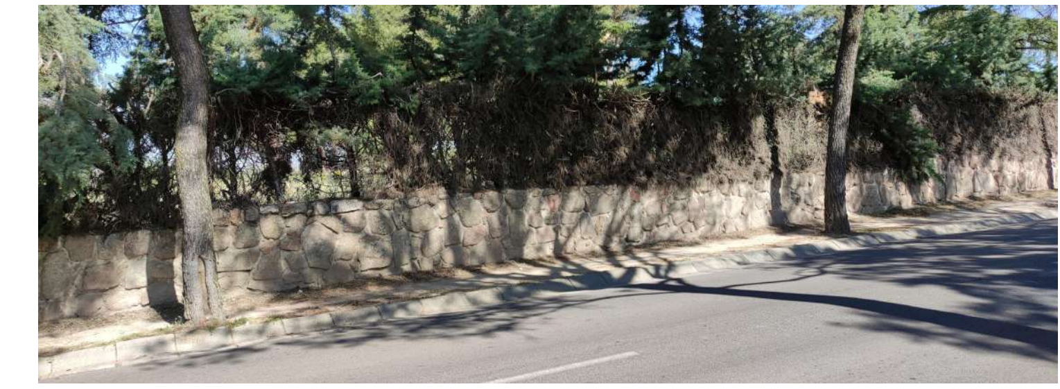
Foto 1. Muro de piedra en buen estado de conservación
