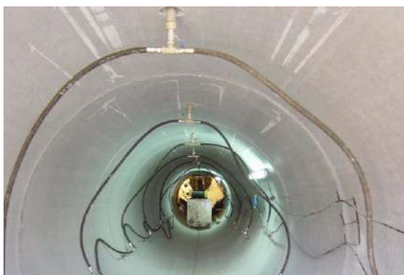
Sistema de inyección de bentonita
