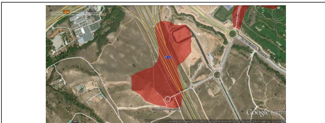
Vista aérea del año 2009 de ubicación con las obras desarrolladas en el lado NE. Google Earth.
