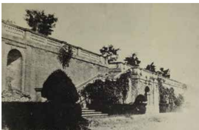
Imagen de la escalinata principal de acceso de la primera a la segunda terraza del jardín
