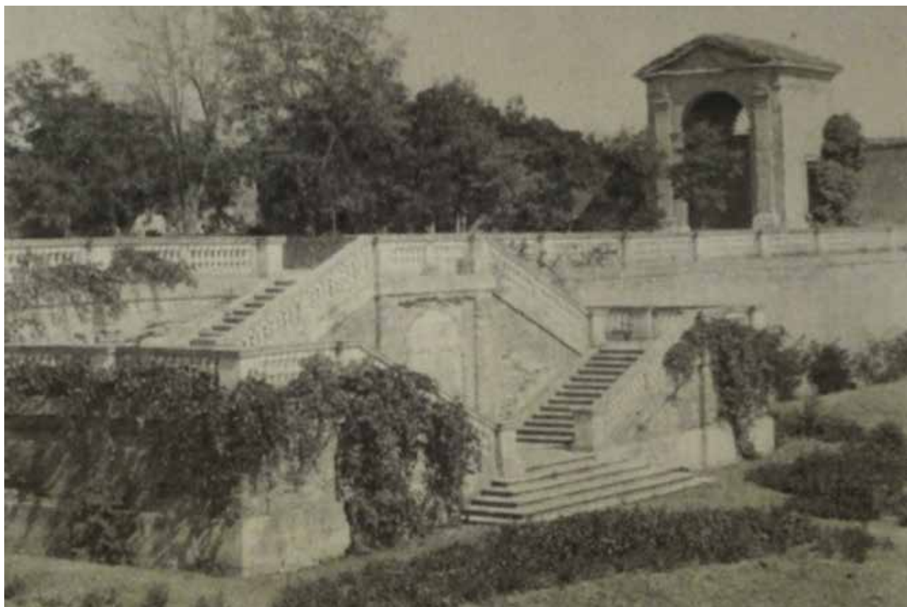
Fotografía de la escalera de acceso a la zona noroccidental de la segunda terraza del jardín
