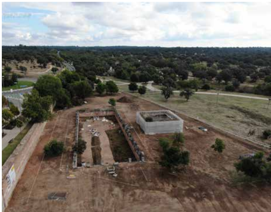
Obras del estanque y la noria
