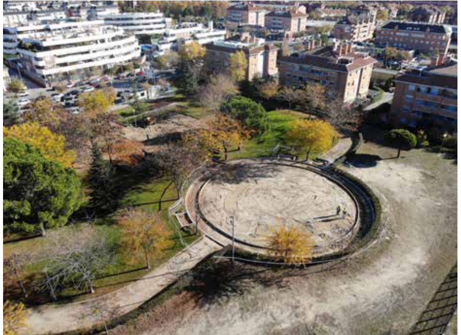
Obras en el parque Hermanos Machado
