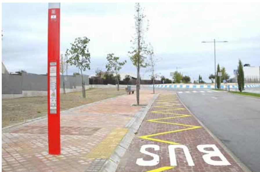
Parada terminal de la L4 en El Pastel
