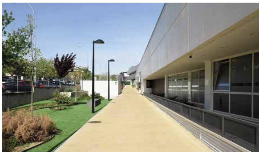
Cámara en la fachada del CD Condesa de Chinchón
