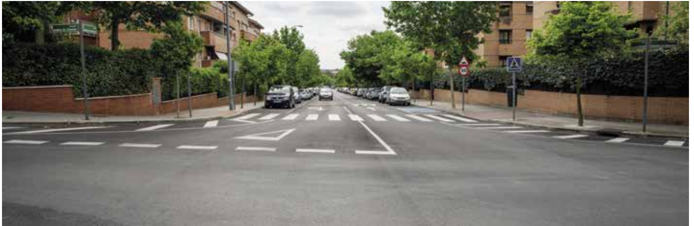
Asfaltado en el Sector B
