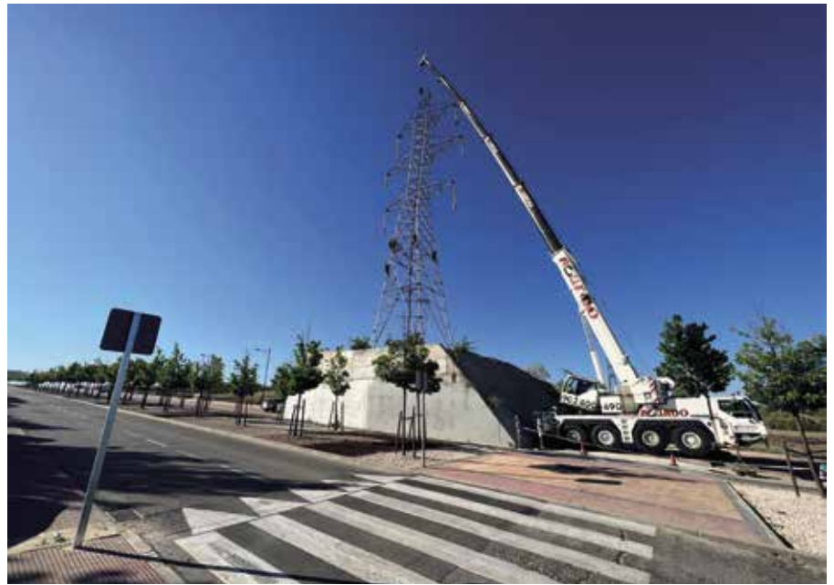
Desmantelamiento de la torre de alta tensión en Valenoso
