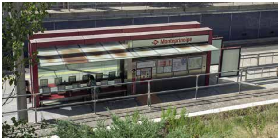
Estación de Metro Ligero en Montepíncipe
