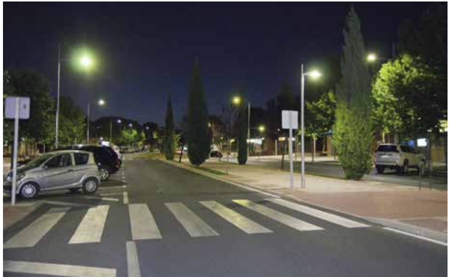
Iluminación en el Sector S
