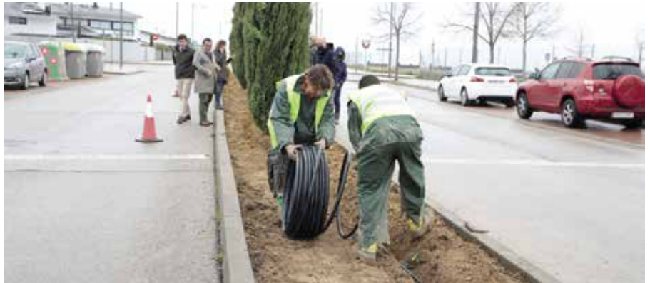
Trabajos de mejora en las medianas
