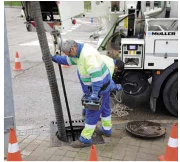
Limpieza en alcantarilla
