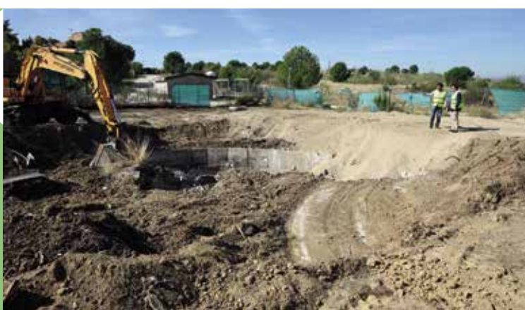
Derribada la antigua depuradora de la urbanización Bonanza
