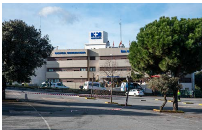
Obras de construcción del edificio universitario
