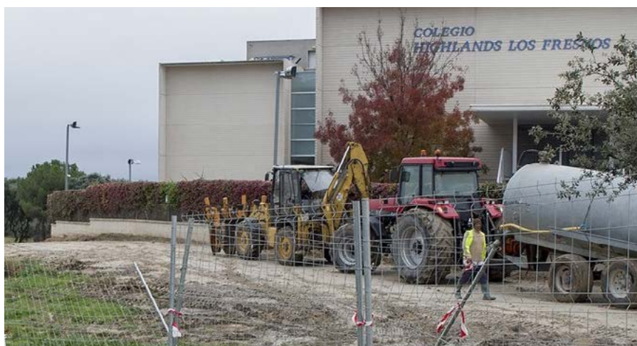
Obras para acondicionar las plazas de aparcamiento
