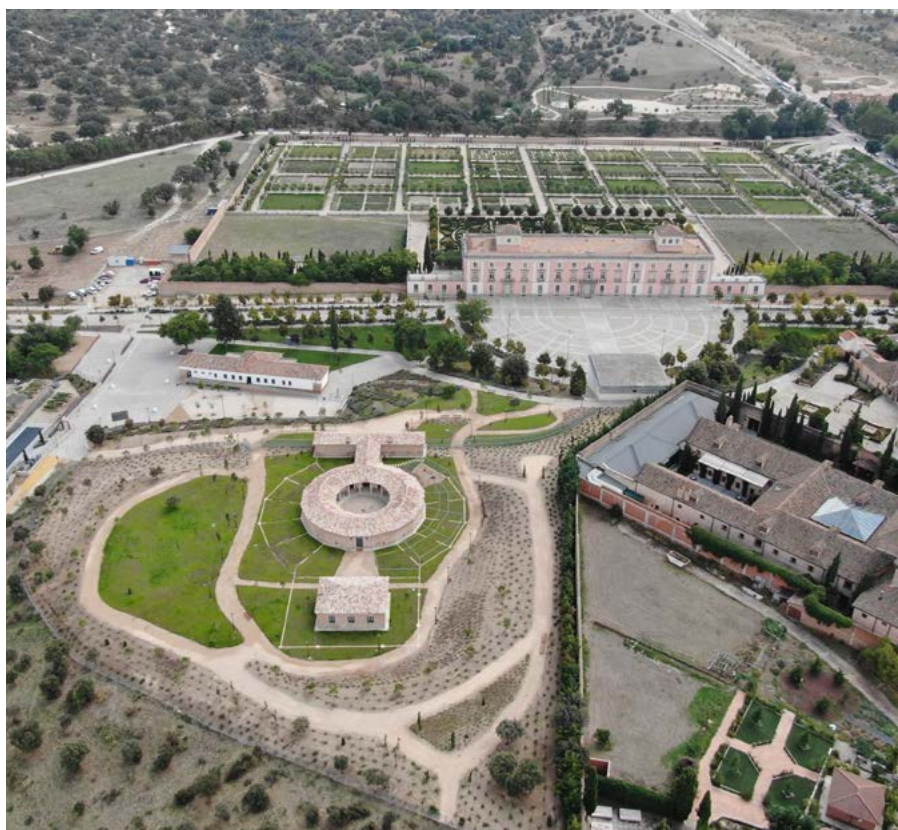
Vista aérea de la Casa de Aves
