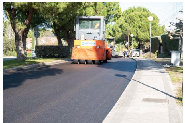
Trabajos de asfaltado
