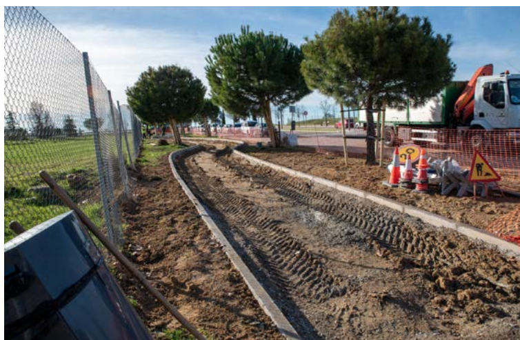
Obras de ampliación del carril bici
