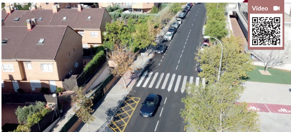
Asfaltado en calle Secundino Zuazo
