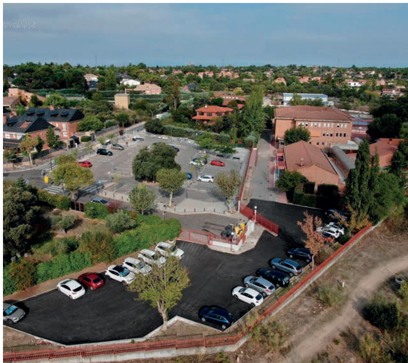
Aparcamiento CEIP José Bergamín
