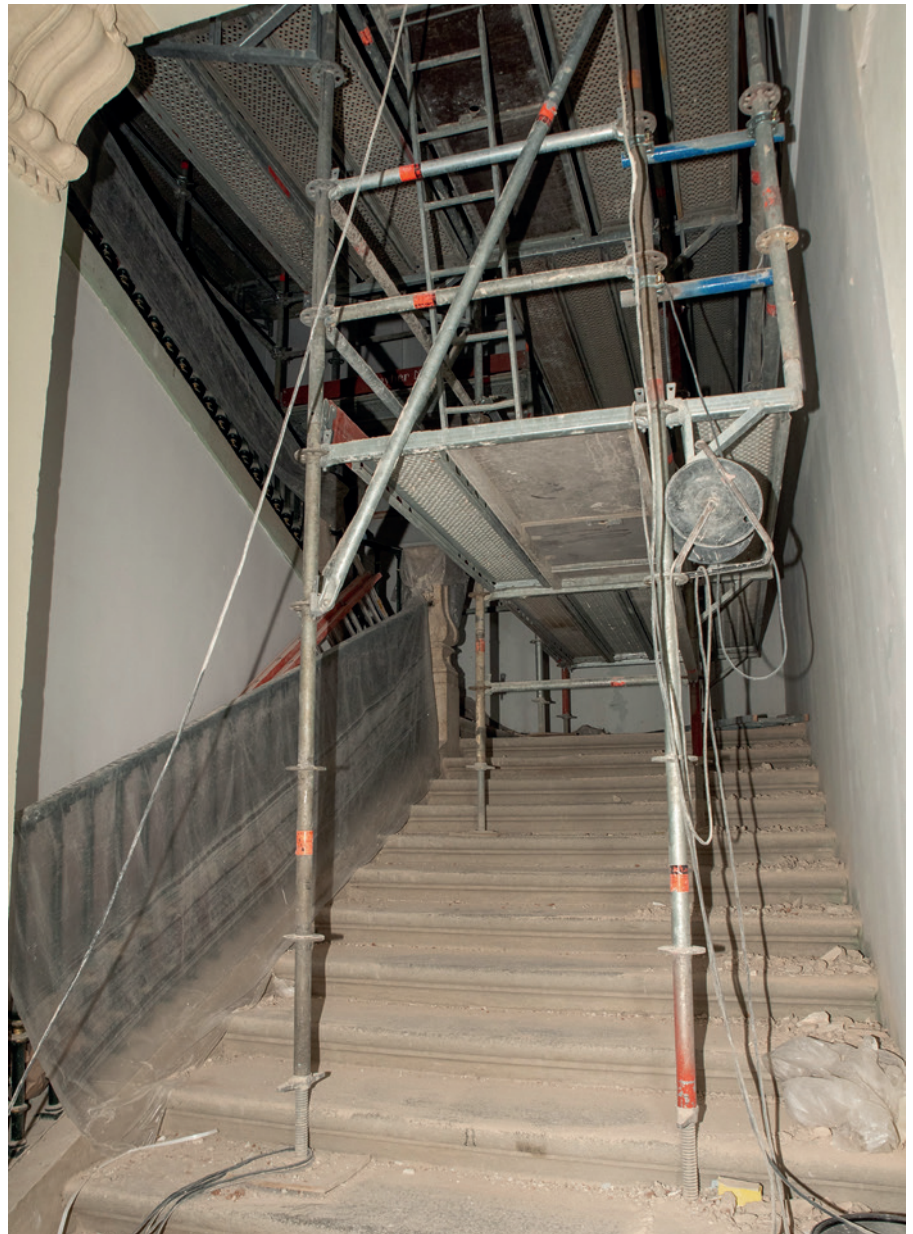
Obras en la escalera principal del Palacio
