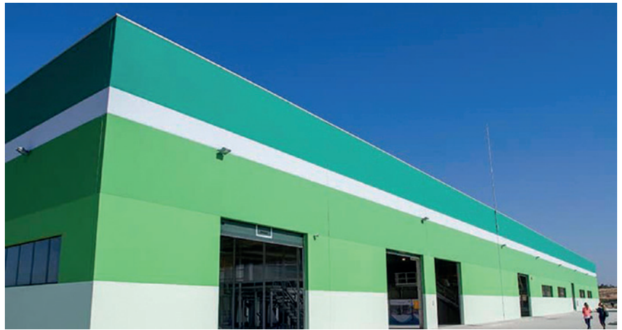
Depuradora de Valenoso
