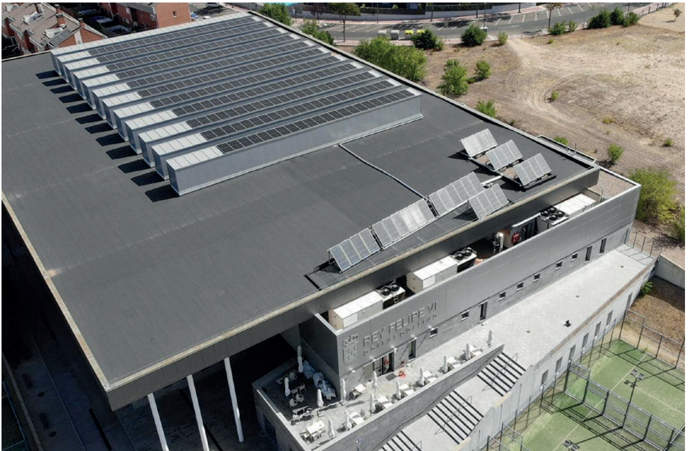
Placas fotovoltaicas en el pabellón Rey Felipe VI
