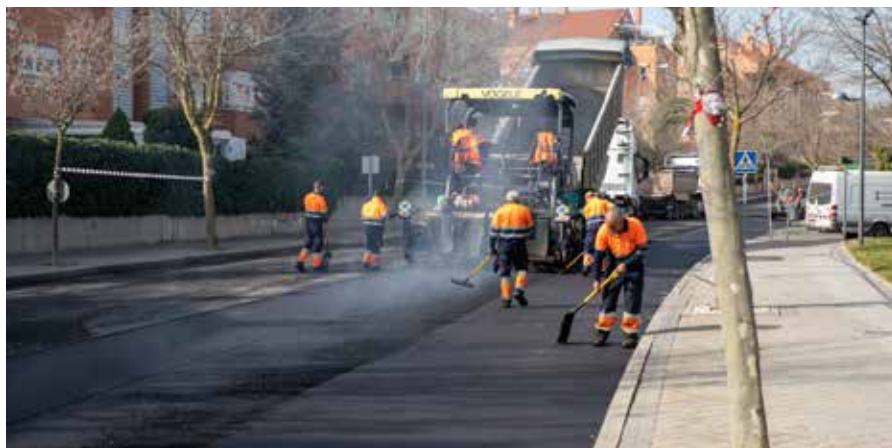
Operación asfalto en la calle Gregorio Marañón
