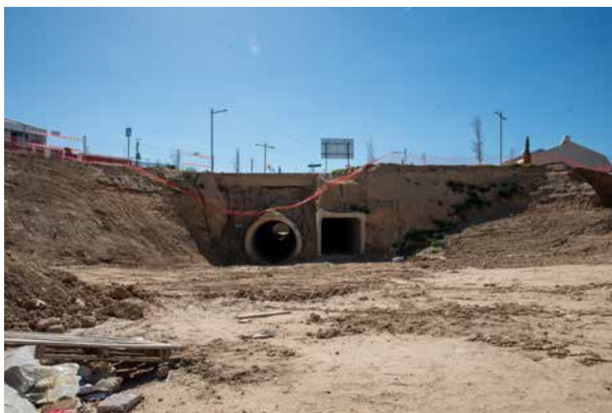
Obras en los cauces de los arroyos
