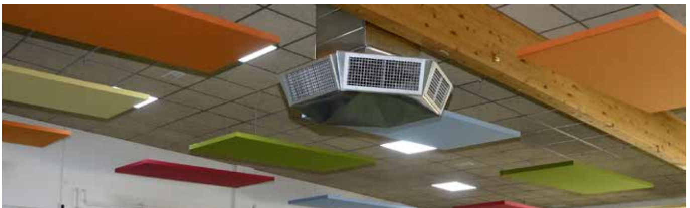
Bioclimatizador en el CEIP Teresa Berganza
