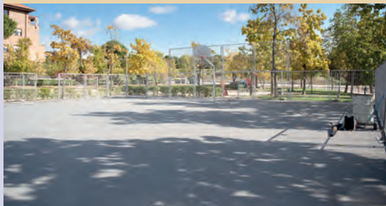
Trabajos de remodelación en la pista de baloncesto del parque de Gregorio Marañón
