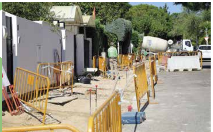
Obras de acerado y construcción de un aparcamiento ecológico en Isla Coelleira (Valdepastores)
